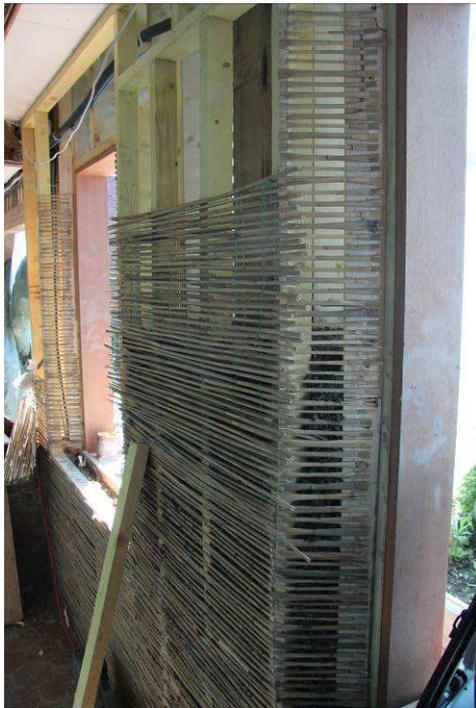
2 – Ensuite, on crée une structure bois intérieur (entraxe 40 cm maximum), sur laquelle on agrafe la natte de roseau au fur et à mesure du remplissage, par hauteur d'environ 50 cm.
